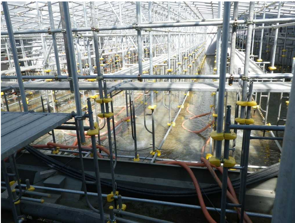
5 外周堰内側溝から内周堰内への雨水移送状況
