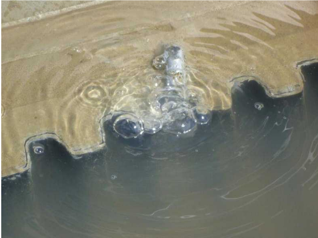
2 外周堰内側溝からの気泡発生状況
