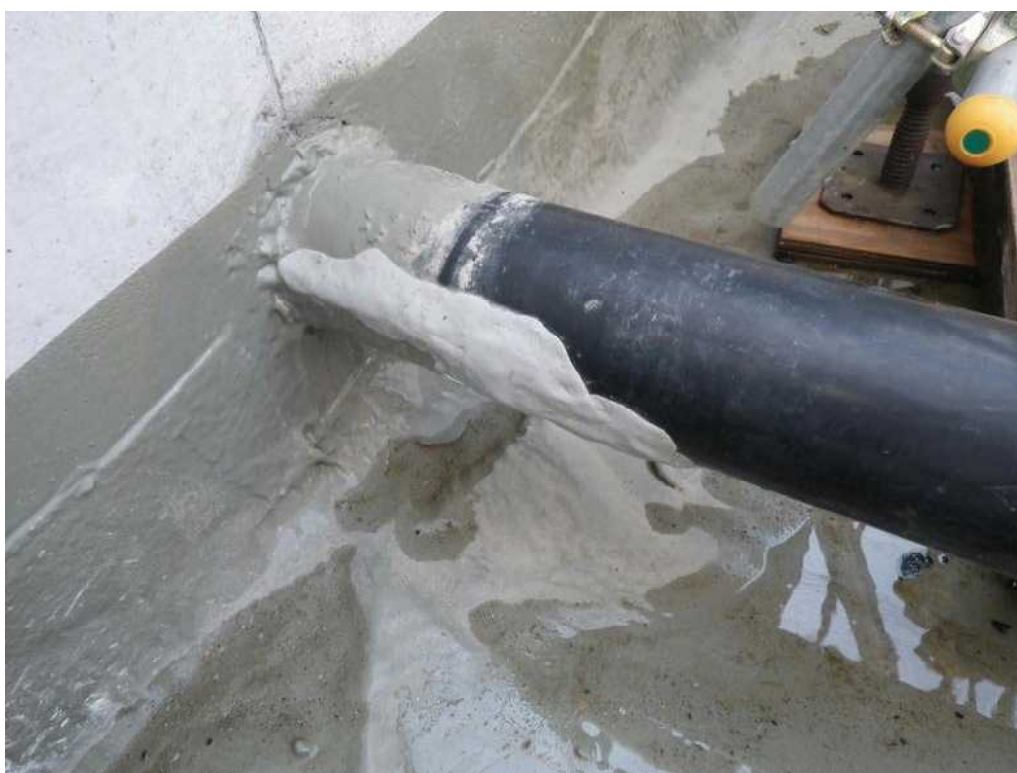
1 内周堰内からの漏えいに関する止水状況
