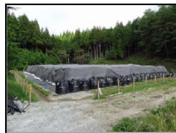
キャッピング完了後
