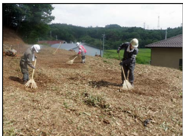
森林(生活圏)の除染状況(堆積物除去)
