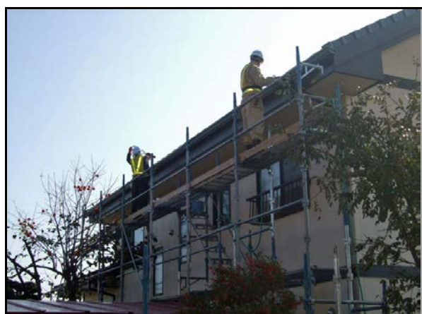
住宅除染実施状況
