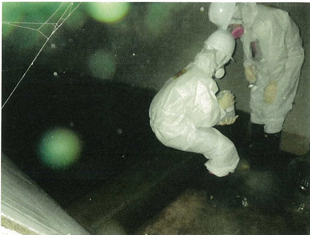
4 側溝放射線モニタ近傍サンプリング
