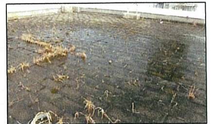
写真④：大物搬入口屋上
