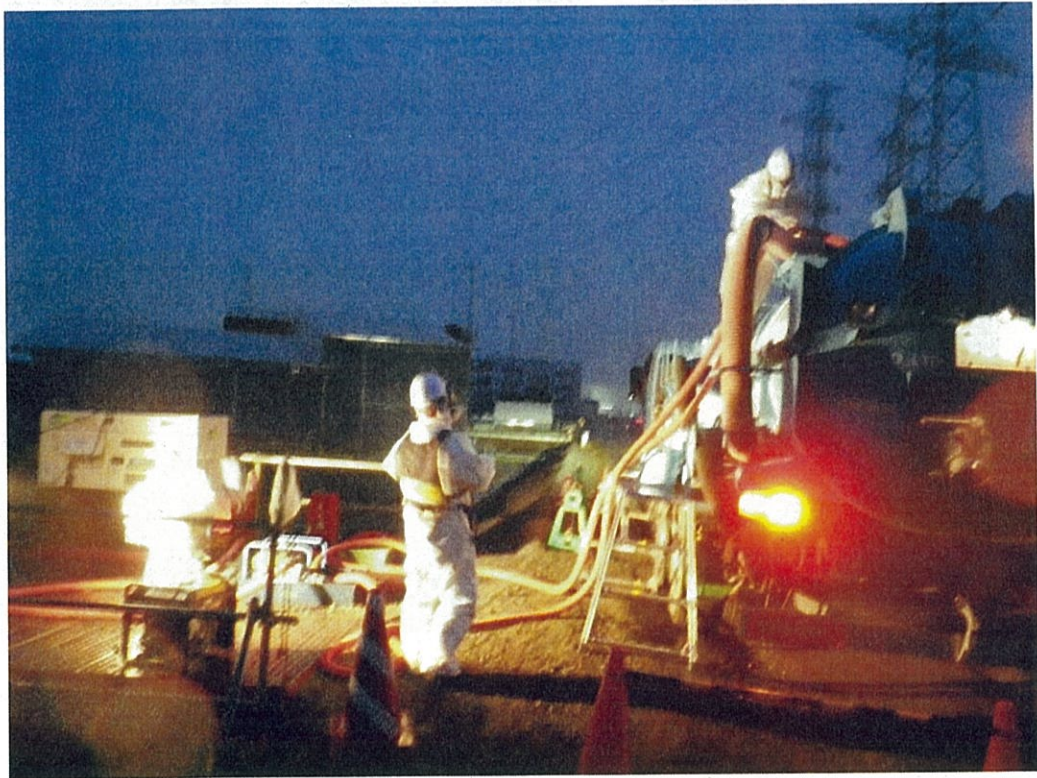
3 汲み上げ水のタンクへの移送作業状況
