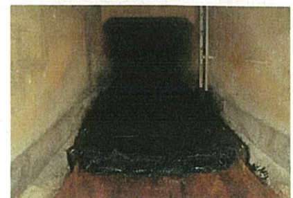
2/10撮影 (K排水路)
