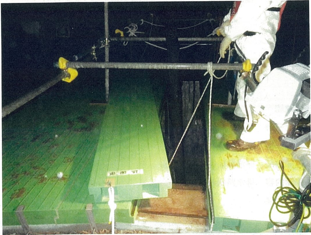
2 排水路雨水吸引状況
