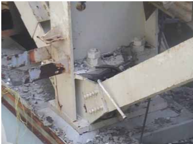
② 9a通り柱脚 健全
