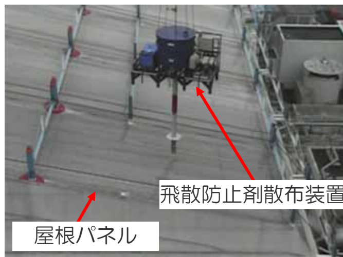
屋根パネルへの孔あけ状況
