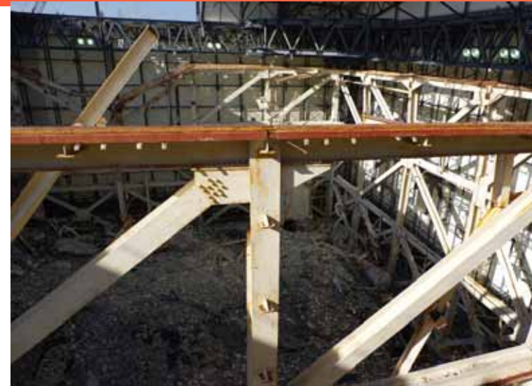
① 7a柱上部梁 健全
