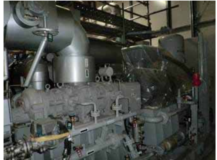
写真 : 冷凍機設置完了・試運転待ち
