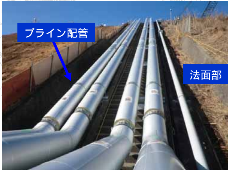
写真 : 法面部ブライン配管設置状況
