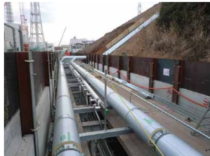
写真 : 5 BLKブライン配管設置状況
