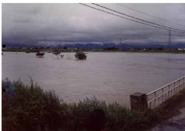
写真 - 2 昭和61年8月台風における旧湯川被害
