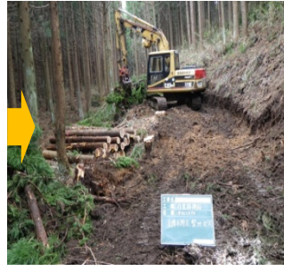
② 作業道整備
