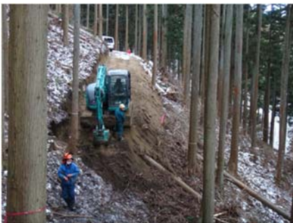
作業道の整備状況
