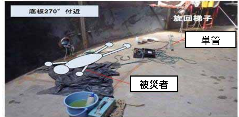
H26.11.7 旋回梯子レールが落下し負傷
