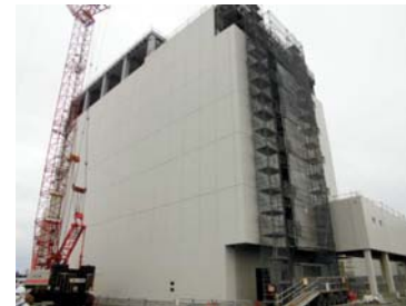
建設中の大型休憩所
