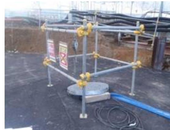
是正後（開口部にバリケードを設置）
