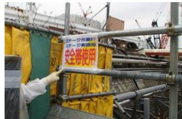
是正後（安全帯使用の標識を設置）
