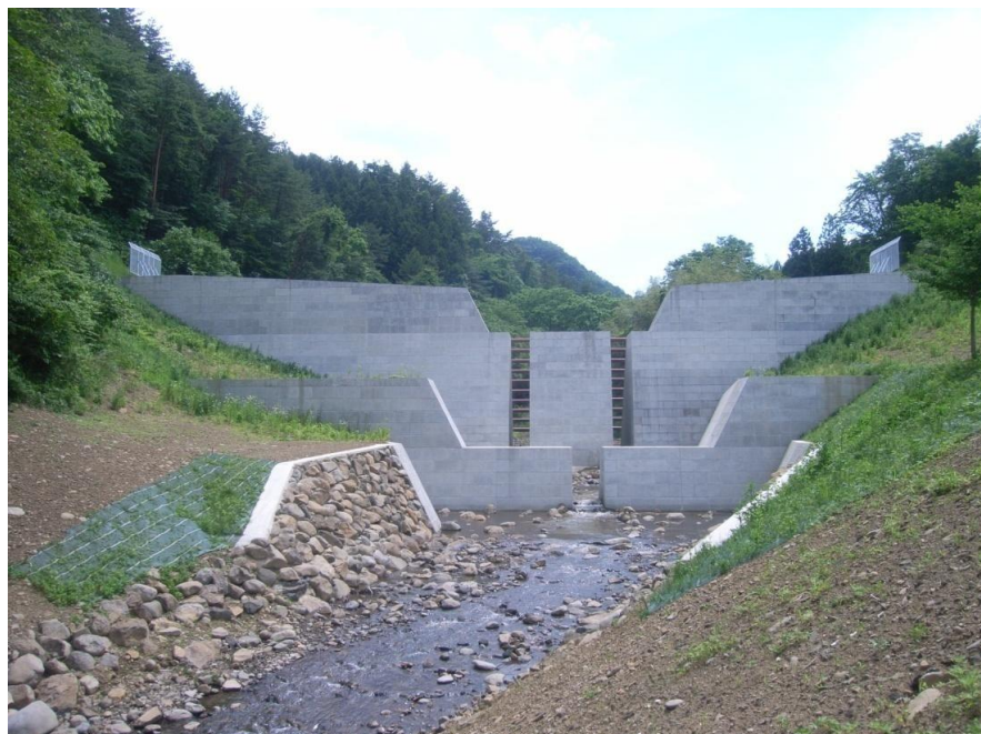
火山砂防 藤入川(福島市松川町水原地内) 平成22年12月完成
