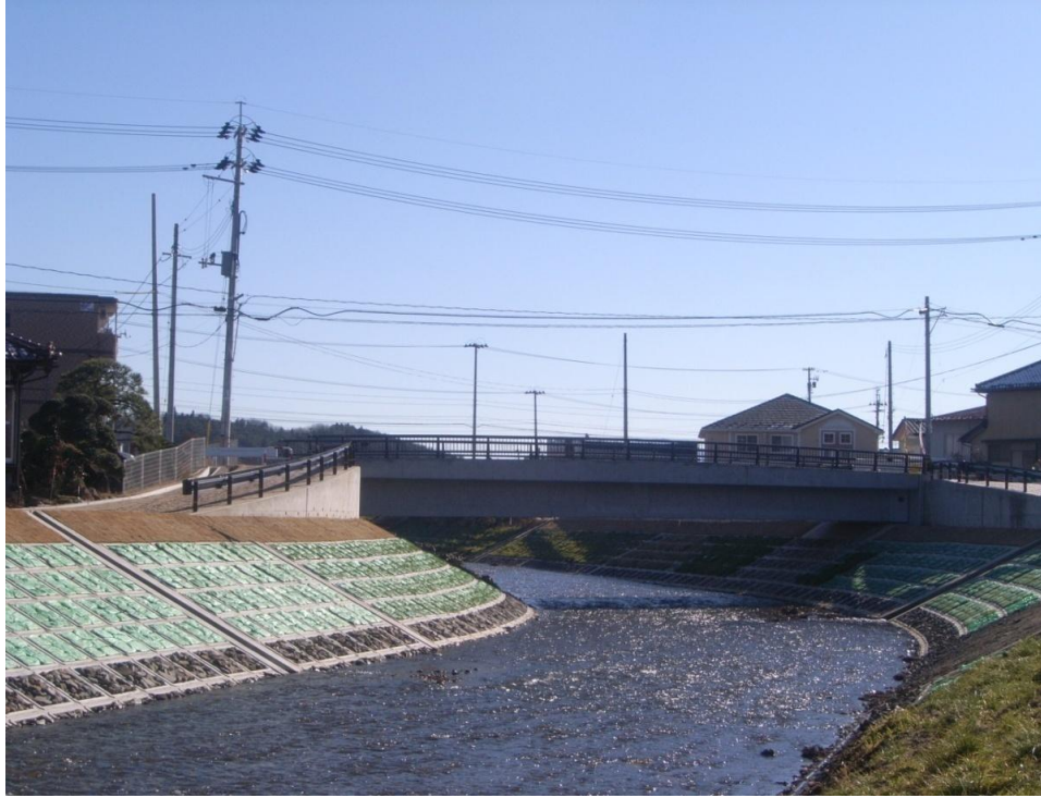
総合流域防災事業〔油井川 二本松市油井字福岡地内〕
