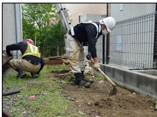
住宅除染での表土の剥ぎ取り作業
