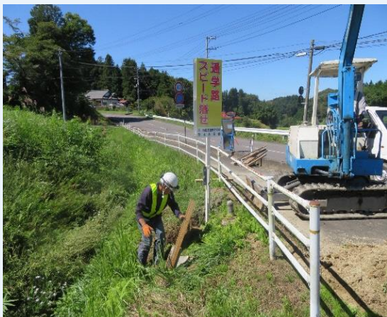
通学路スピード落せ看板設置
