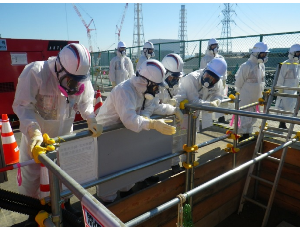
K排水路追加対策（上流部排水路→B排水路）設置現場
