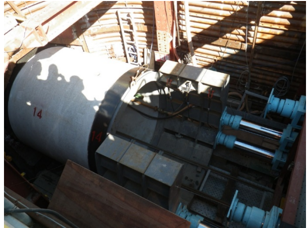
発進立て坑（トンネルを掘りながらヒューム管を押し込み排水路を作る）出発地点
