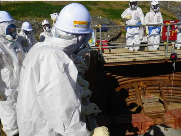
K排水路付替工事現場
