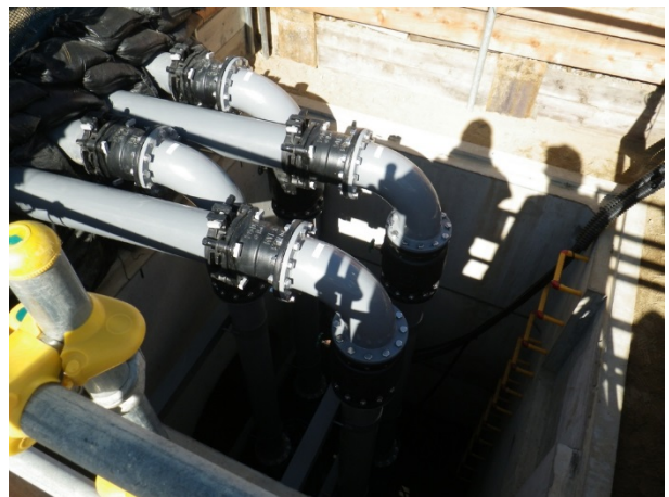
仮設ポンプ（4台）の状況（枝排水路の集水弁からB排水路へポンプ移送する）
