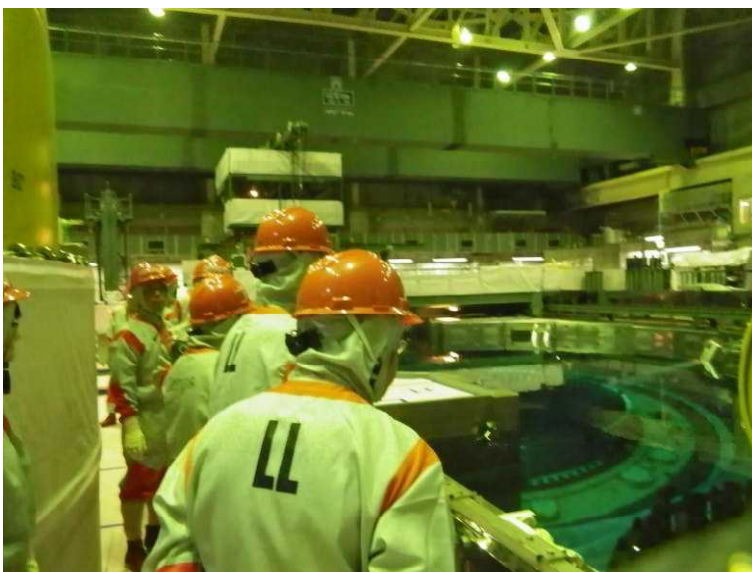
・オペレーティングフロア。右下に原子炉上部が確認できる。正面やや左には燃料取替機が確認される。
