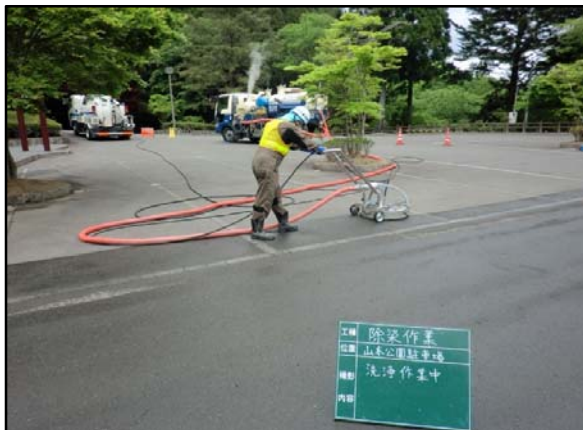
山本公園駐車場除染状況
