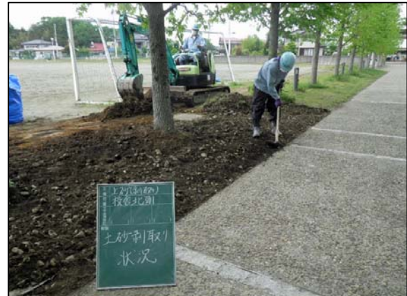
社川小学校除染状況
