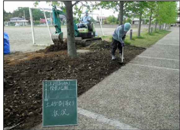
社川小学校除染状況
