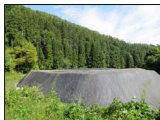
高内仮置場全景
