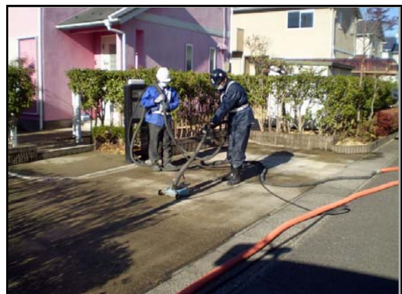
コンクリート洗浄作業
