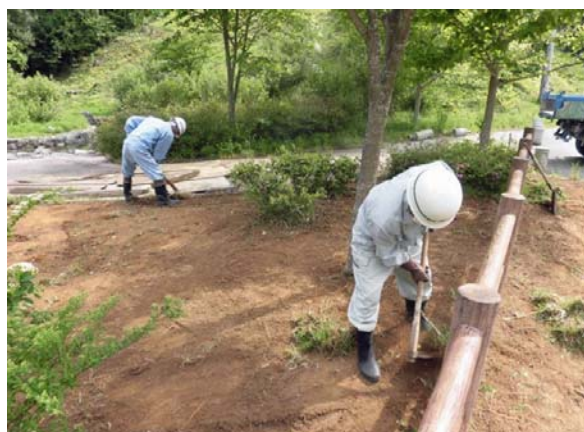
除染作業状況(公園施設)
