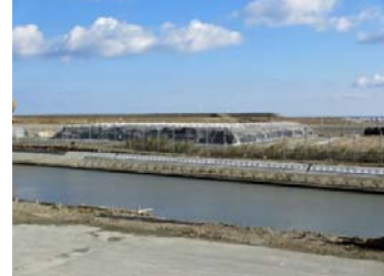
土のう設置状況
