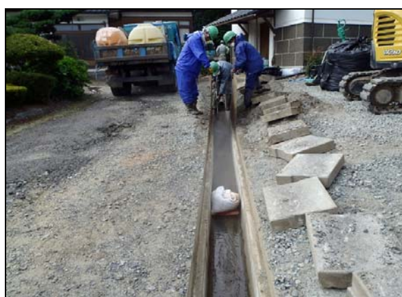
側溝の高圧洗浄
