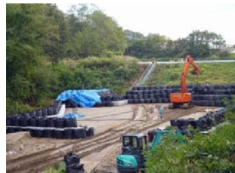
周辺を遮へい土のうで覆い、除去土壌等を据付
