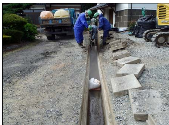
側溝の高圧洗浄
