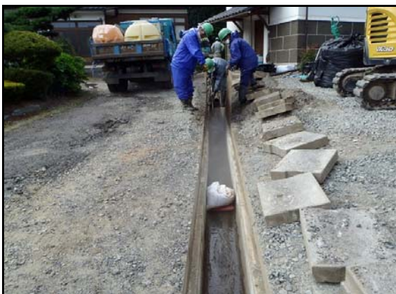
側溝の高圧洗浄
