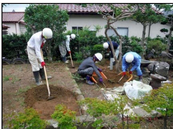
除染作業(表土除去作業)
