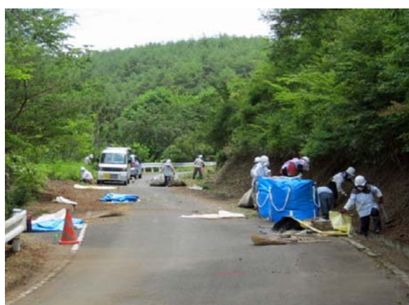
住宅除染での表土の剥ぎ取り作業
