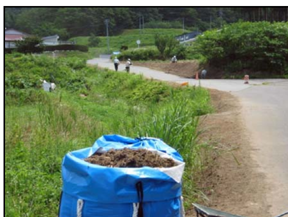
道路除染状況
