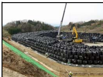
仮置場 搬入中
