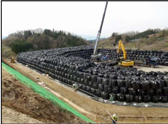
仮置場 搬入中
