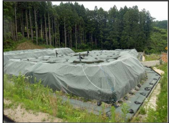
仮置場 搬入済み
