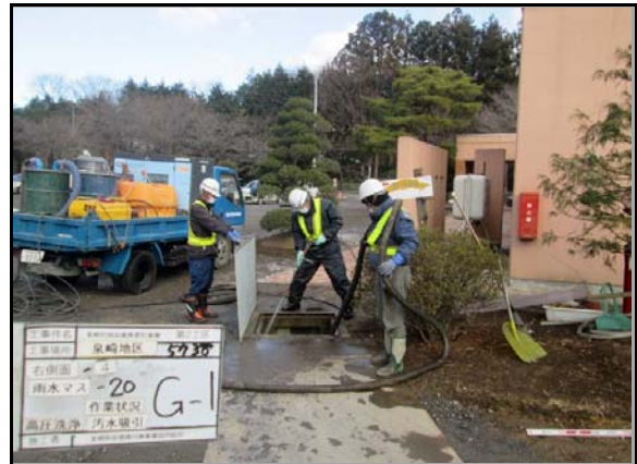
柵除染作業状況
