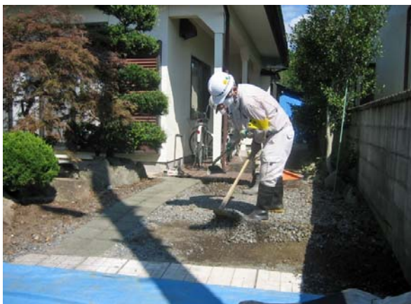
砂利・碎石の除去
