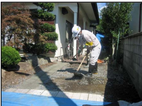
砂利・碎石の除去
