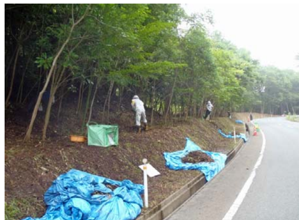
道路路肩除染作業 (H25当時)
