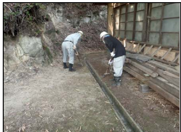
除染実施状況
