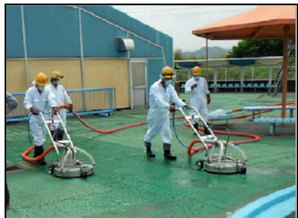
同時吸引型高圧洗浄実施
