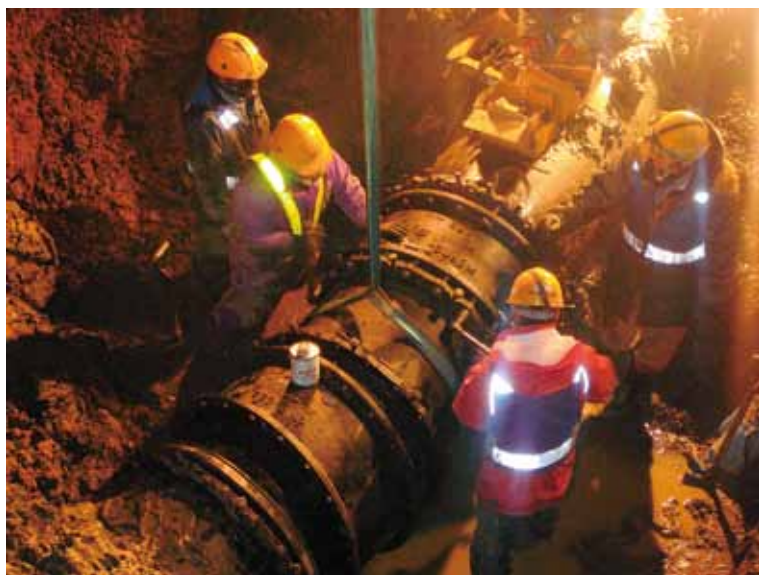
浄水場送水管漏水の修理
