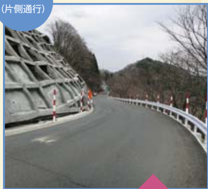
復旧後 (片側通行)
