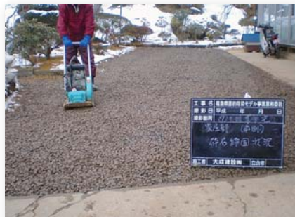
庭の砂利除去と敷均し転圧
