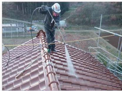
屋根の高圧水洗浄
