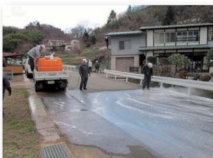
洗剤による高圧水洗浄
