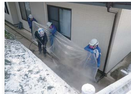
家屋内側溝の高圧水洗浄(除染済の外壁の保護)
