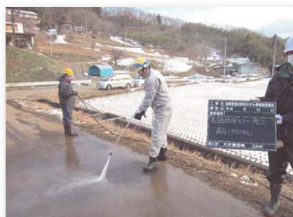
超高圧水洗浄
