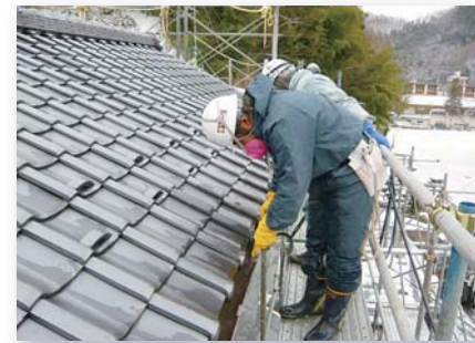
雨樋の堆積物の除去
