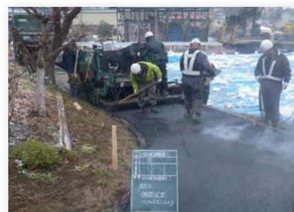
砂利道の表面遮へい（As舗装）
