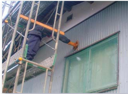
外壁の拭取り
