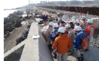
海岸保全施設「北海老地区」 (南相馬市)の査定状況
