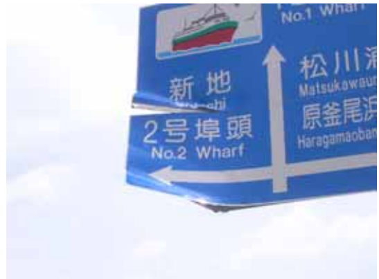
案内標識の破損
