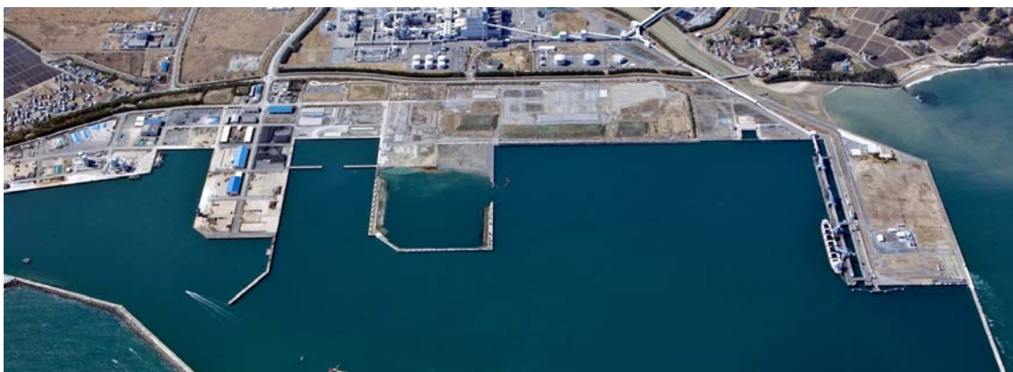
建設中の3号ふ頭
