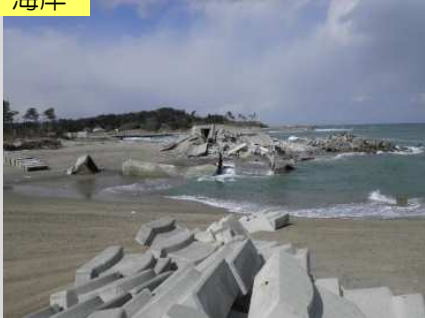
木崎海岸の被害状況(3/29)
