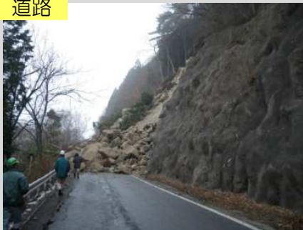
白河羽鳥線の被害状況(3/15)
