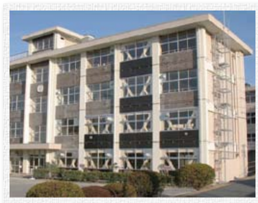
●耐震工事を行った校舎
