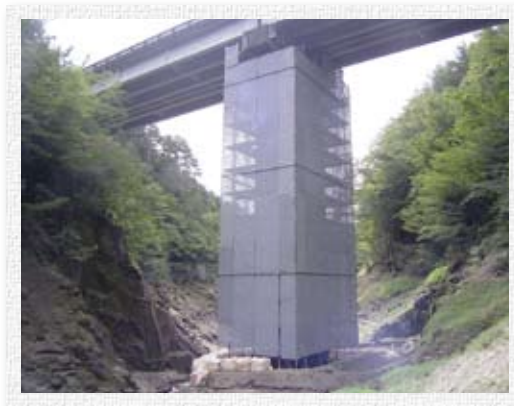
●橋梁の長寿命化工事
