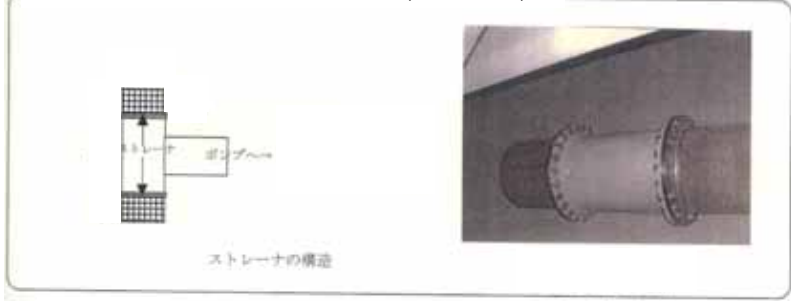
非常用炉心冷却系ポンプの吸い込部(ストレーナ)例
