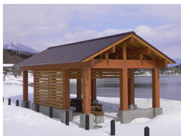
事業施工状況(猪苗代町)
