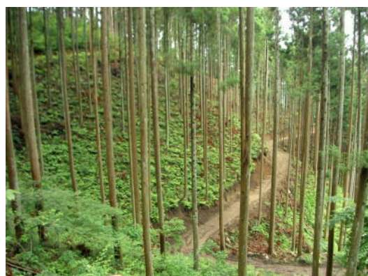
作業路整備(施工後)(田村市)
