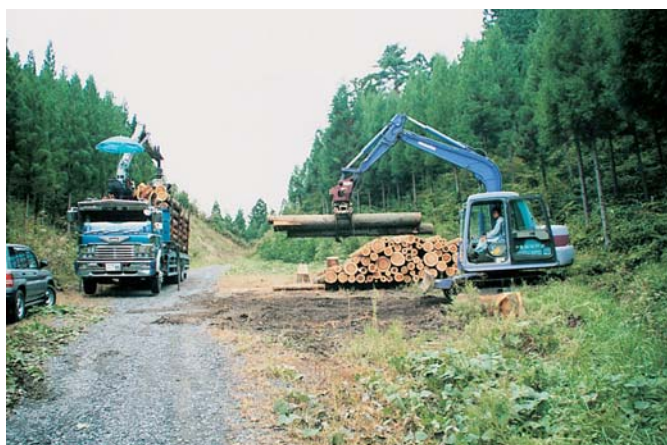
素材の搬出（いわき市）
