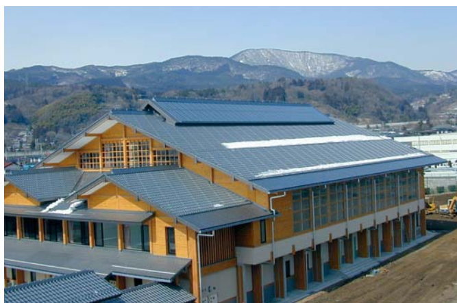
県産木材を多用した桑折町地域交流センター（桑折町）
