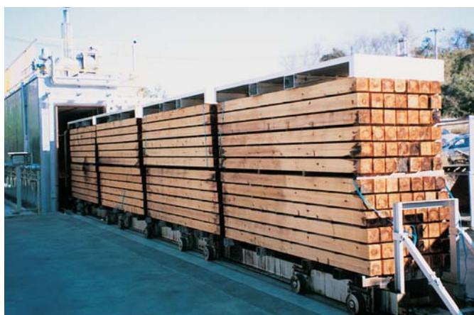
磯いわき木材加工センターの木材乾燥施設(いわき市)
