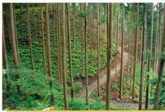
作業路開設 田村市
