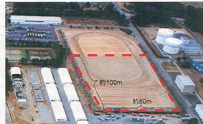
使用済燃料乾式キャスク仮保管設備 (グラウンド内東側)
