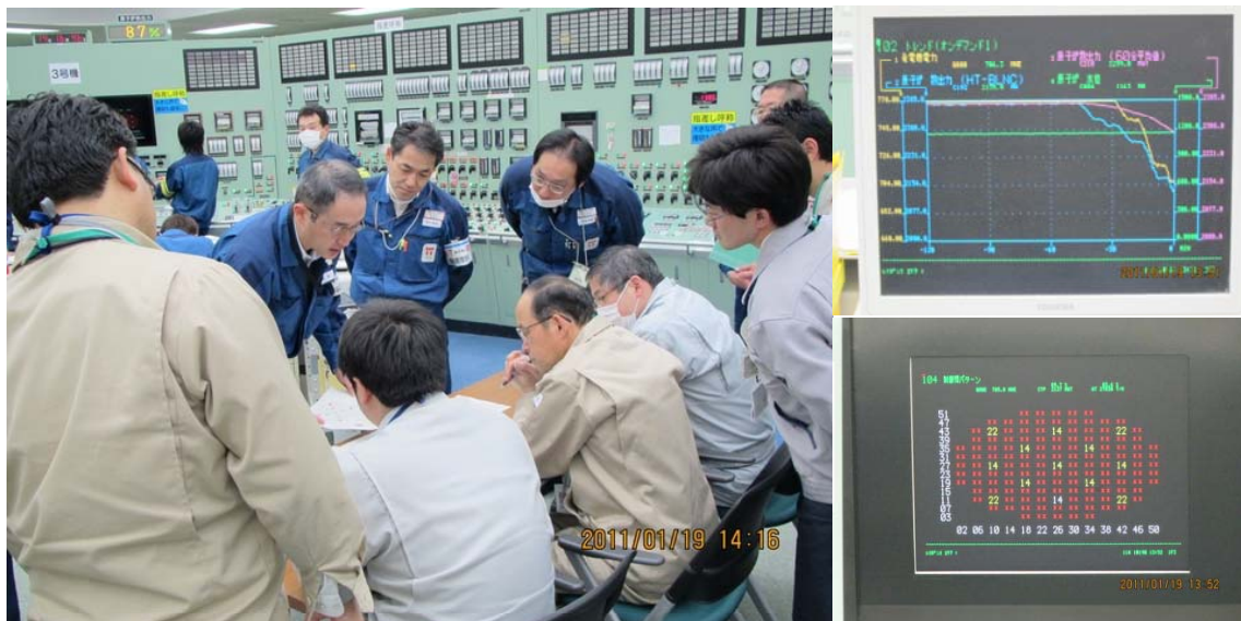
最小限界出力比及び燃料棒最大線出力密度の状況について確認 (発電機出力、原子炉熱出力及び原子炉水位の推移(右上)、制御棒挿入位置状況(右下))
