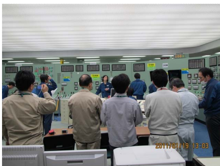
制御棒パターン調整実施状況の確認
